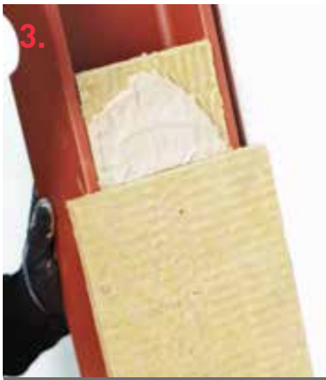
Conlit Klæber mellem passtykke og Conlit beklædning. Placer et passtykke bag samlingen af to Conlit plader.
