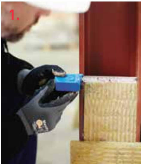
Tilskær passtykkerne stramt og kløb med Conlit Klæber mellem profilet's flanger.
