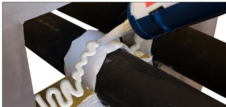
Fug med FireFree® B722 Brandmastik. Det sikrer en god vedhæftning mellem brandplade og konstruktion og sørger for tæthed mellem brandplade og installationer
